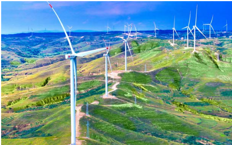
蒙西托克托170万千瓦风力发电项目
