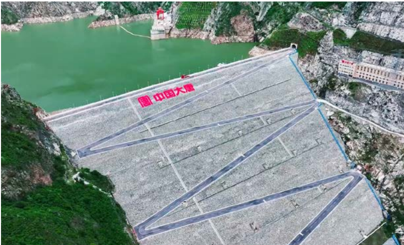
四川甘孜水电公司
