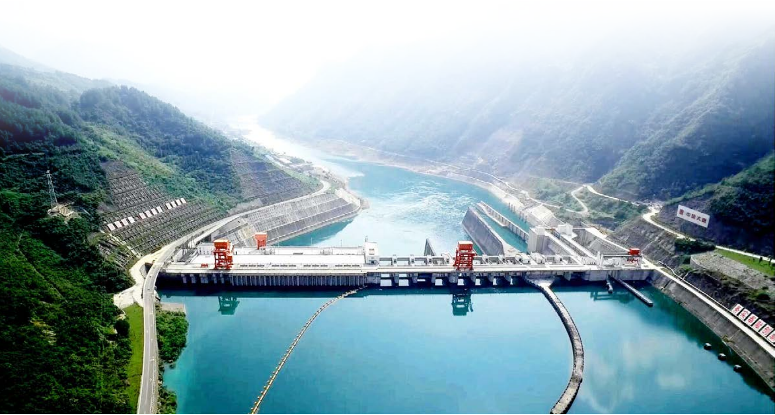
重庆武隆银盘水电站
