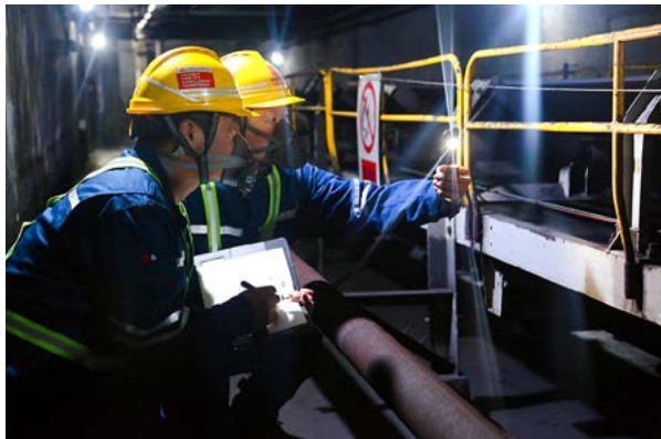
黑龙江公司绥化热电公司定期检查输煤皮带运行情况
