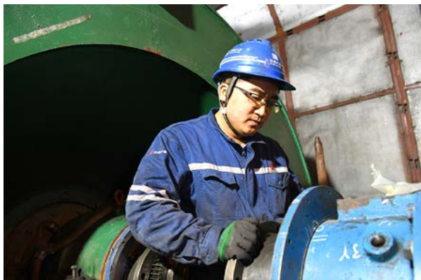
辽宁分公司锦州热电公司开展设备检修
