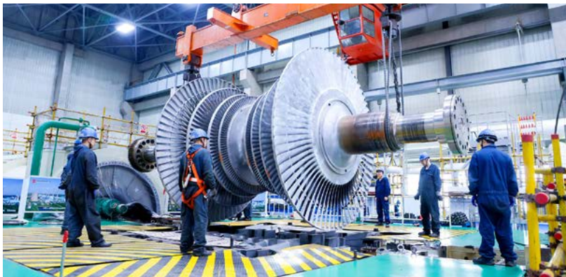
大唐国际系统企业扎实开展设备检修工作，为机组安全稳定运行筑牢坚实防线
