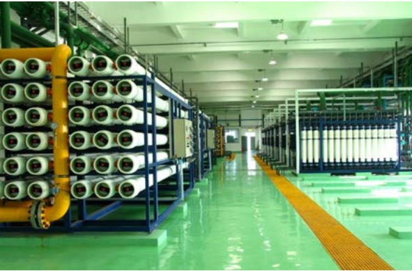
王滩发电公司在国内投运了首个采用双膜法（UF+SWRO）海水淡化系统，高效利用水资源
