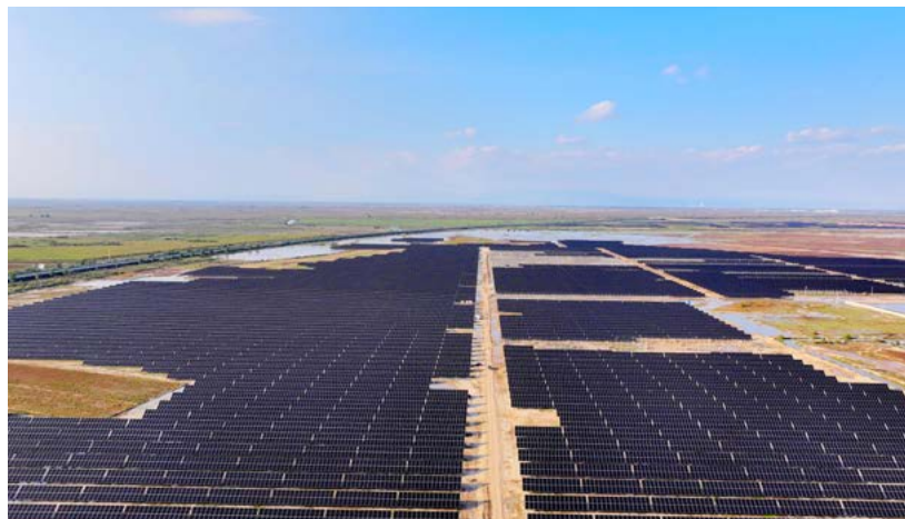
呼和浩特铝电公司燃煤自备电厂可再生资源替代 360 兆瓦光伏项目
