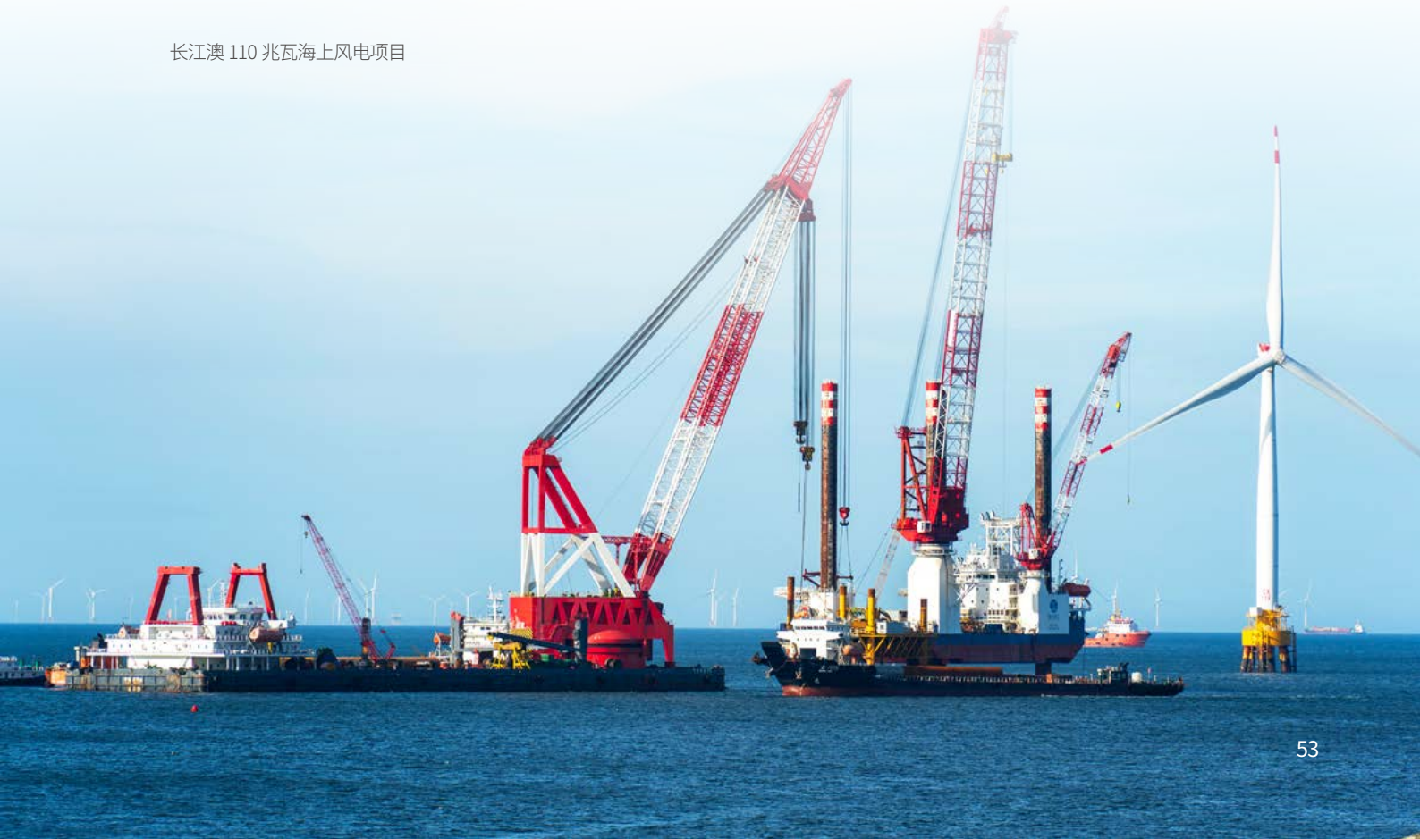
顺利完成项目首台负压桶体沉贯施工，负压桶体水平度在负压沉贯全过程控制在 2‰以内，达到世界领先水平
