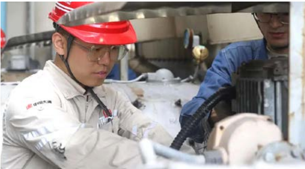
江苏如皋热电公司开展机组检修
