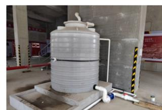
长沙北辰三角洲 A2 项目现场设置雨水收集水箱，收集后用于现场降尘洒水及洗轮机补水
