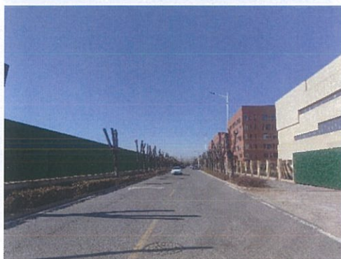
南侧联东U谷·马坡科技园二期项目
