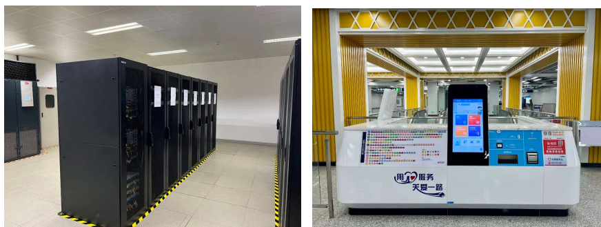
南京地铁 5 号线的云节点机房与智能客服终端
