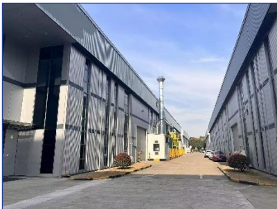
估价对象内部
