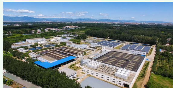
北京市房山區良鄉污水處理廠 BOT 項目
