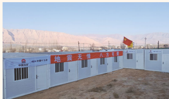
援建青海循化撒拉族自治縣街子鎮抗震救災活動板房
