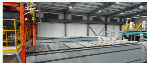
寧波海靖飛灰中低溫熱解 EPC 項目
