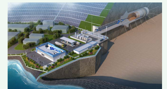
50,000Nm 3 水平隧洞式岩洞氫儲能系統
