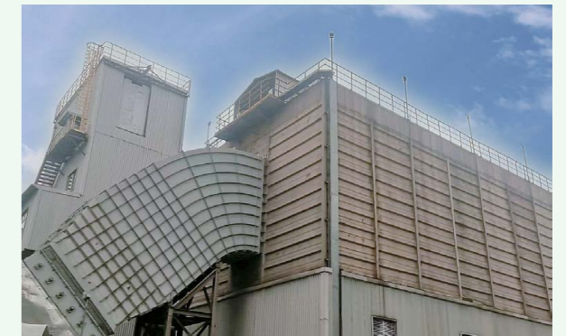
寶山基地環境除塵系統節能改造 EMC 項目
