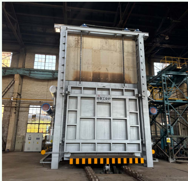
爐窯升級改造項目
