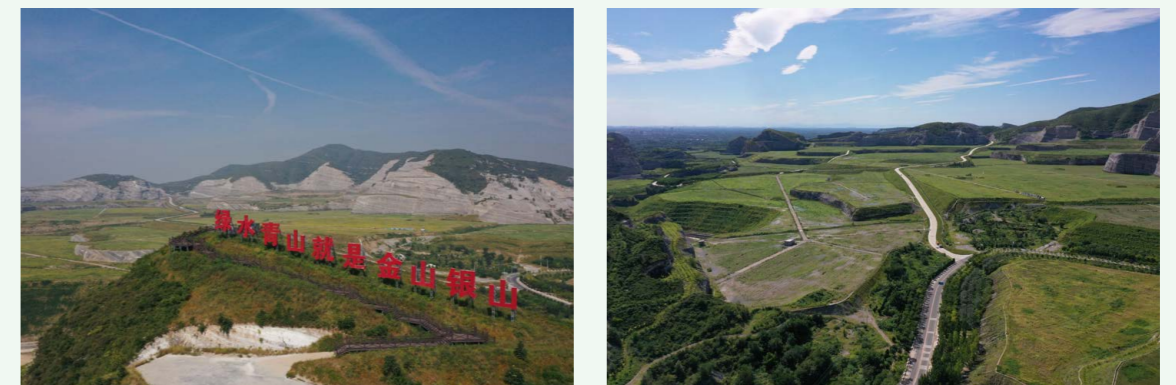
三河東部礦區礦山地質環境治理項目
