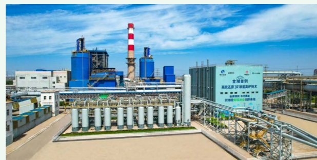
3R 碳氫高爐 EPC 項目
