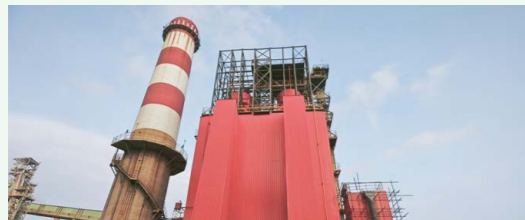
廣西盛隆熱風爐煙氣超低排放改造項目
