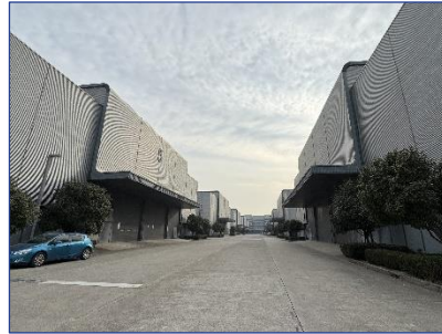
估价对象内部
