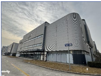
估价对象内部
