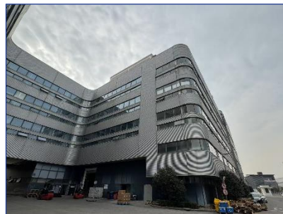
估价对象内部
