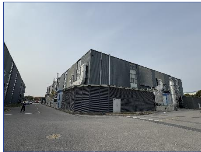
估价对象内部
