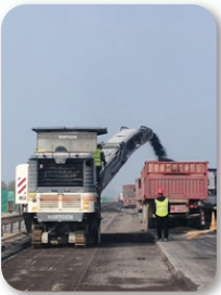
沙河特大橋橋面銑刨
