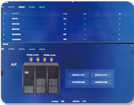
設置空調自動開關
