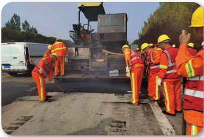
採用厚1.5厘米低碳超韌薄層新技術施工中
