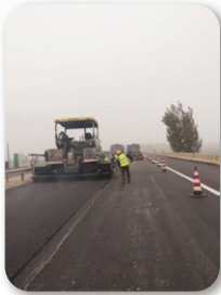
沙河特大橋上面層攤鋪現場
