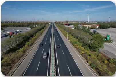
養護後的沙河特大橋橋面
