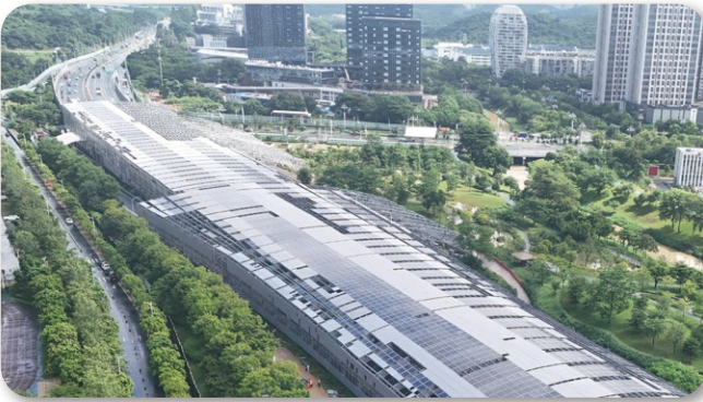
全國首創既有線十車道高速公路上新建的全封閉聲屏障項目：北二環高速保利羅蘭社區段全封閉聲屏障建設工程，上部鋼結構施工現場航拍圖
