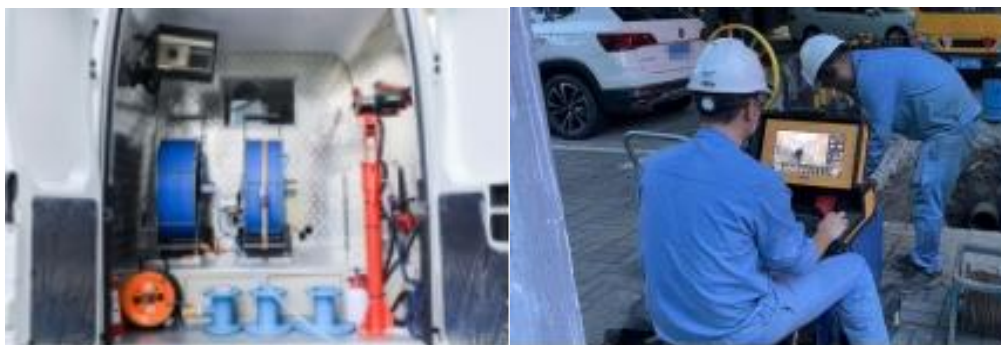
管道检测工程案例
