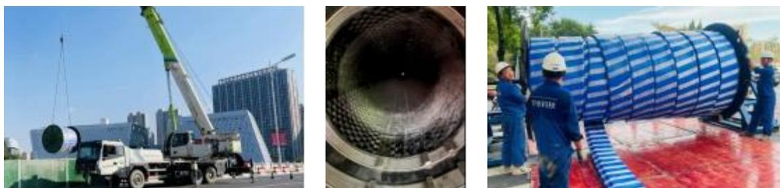
图 22 非开挖修复工程案例
