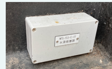
車站出入口安裝水浸感應器
