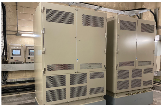
車站的節能換流系統
