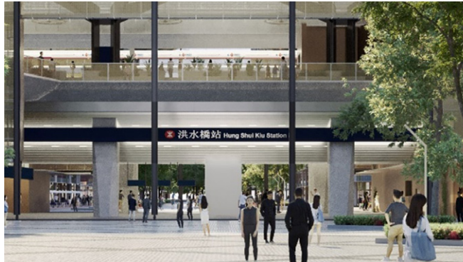
模擬洪水橋站*大堂採用節能設施
