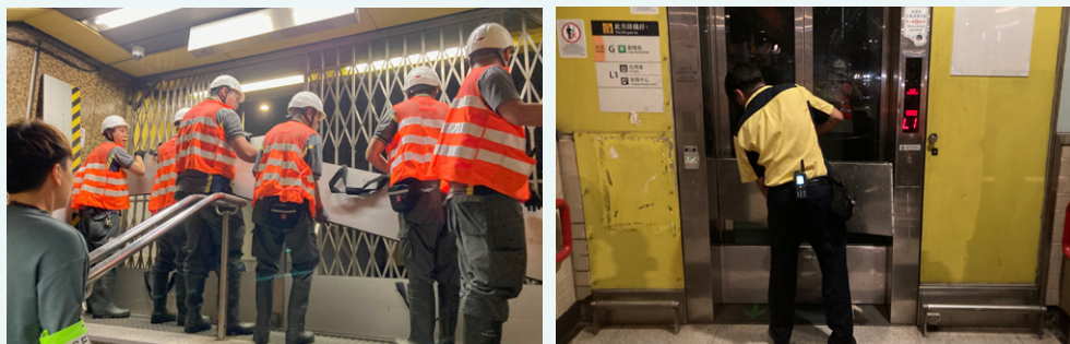
黃大仙站安裝防洪板
