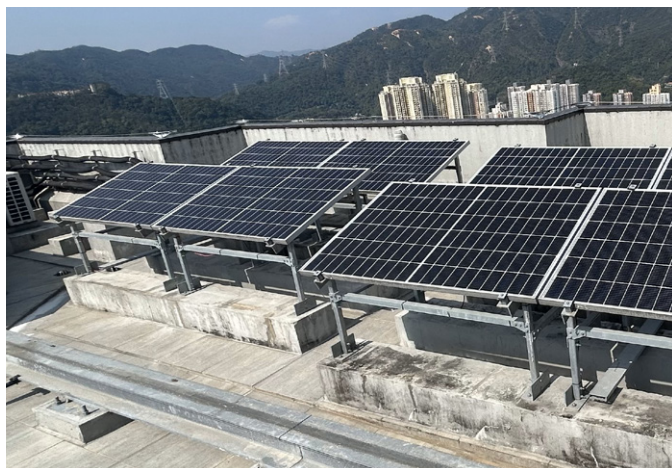
於柏傲莊安裝太陽能發電板（左圖）及風力發電系統（右圖）
