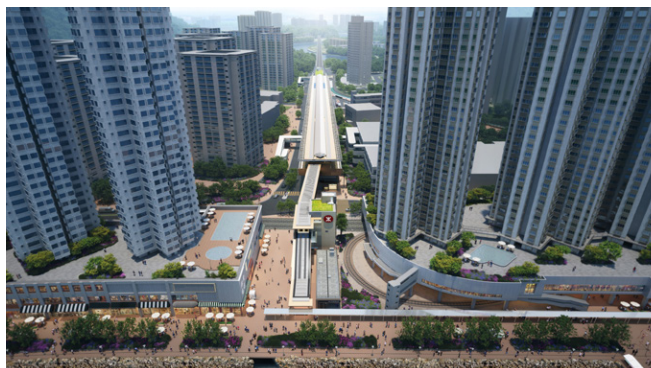
模擬屯門南站*的纖巧車站設計，減少佔用道路面積，並充分利用自然通風廊道，促進車站內的空氣流通與對流
