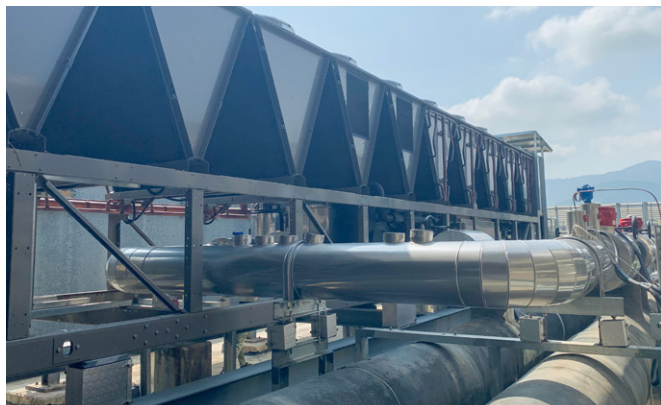
更換錦上路站的空調冷卻裝置
