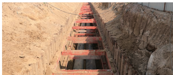
公司融資支持的供熱管網項目建設施工現場
