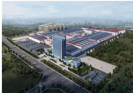
图6：NCC钢结构应用于高端电子厂房
