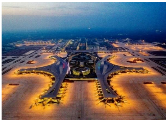
图7：NCC钢结构应用于大跨度公共建筑
