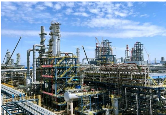
图5：NCC钢结构应用于石油化工领域
