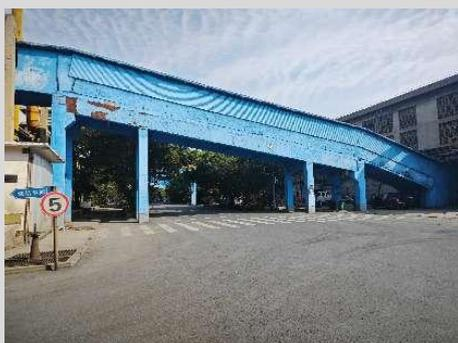
韶关冶炼厂烧结 3#皮带廊围闭
