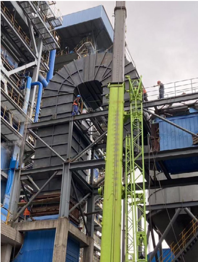
江苏热电脱硫废水
