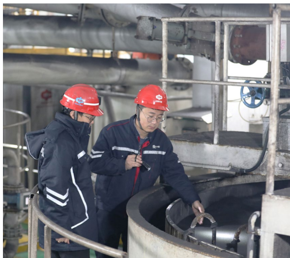
华晋集团所属热电厂机组检修管理和设备运行维护一线
