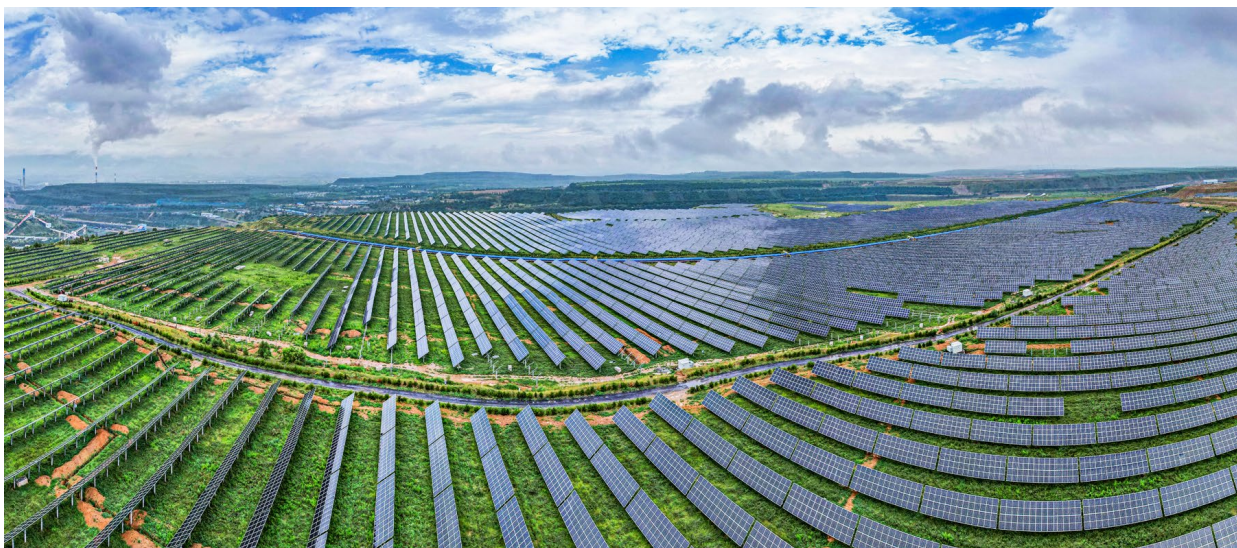
平朔集团 100 兆瓦光伏项目
