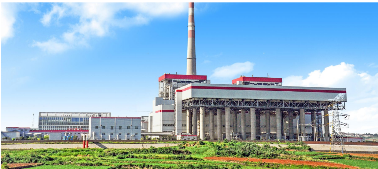
华晋集团晋城热电经过煤电机组超低排放改造，大气污染物减排超 1,000 吨
