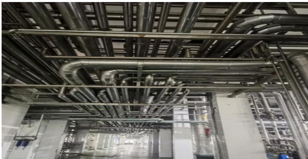
图：节能无死角焊缝改造
