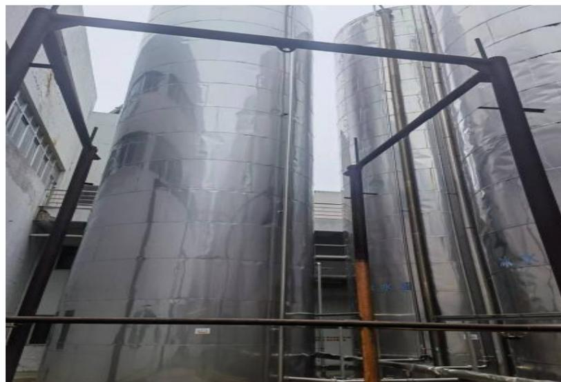
图：热水储能罐
