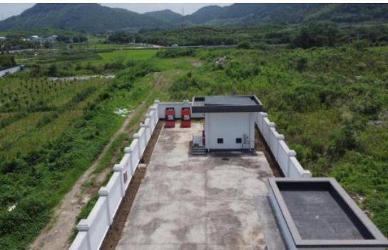
燃气微管网项目设施
