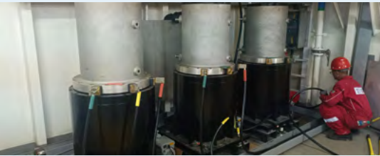
安装飞轮储能装置
