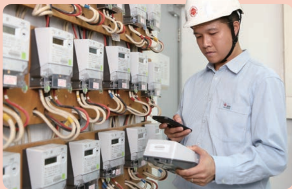
● 港燈工程師為客戶安裝智能電表，整個項目涵蓋所有客戶。
