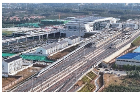
● 山東分公司開展濰煙高鐵5G工程建設
