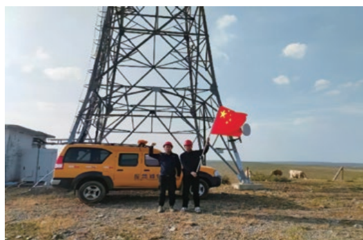
● 內蒙古分公司在錫林郭勒草原進行鐵塔運維
