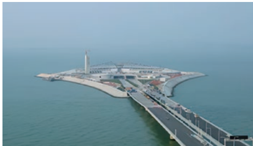
● 公司助力深中通道全線5G覆蓋網絡，打造大灣區「交通脊樑」
