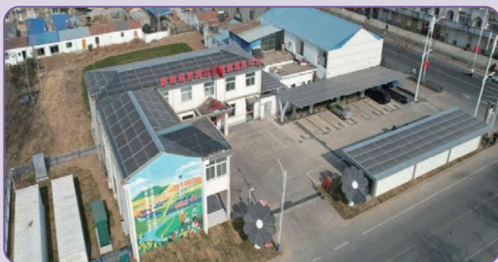
零碳智能微网示范项目
