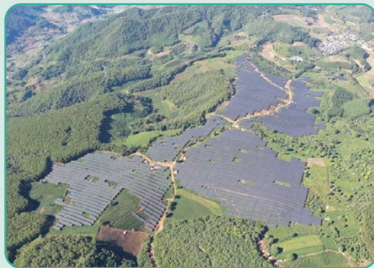
华能普洱集中式光伏项目
