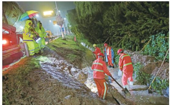
德莘養護清障分中心工作人員連夜搶修強降雨後的排水溝水毀
