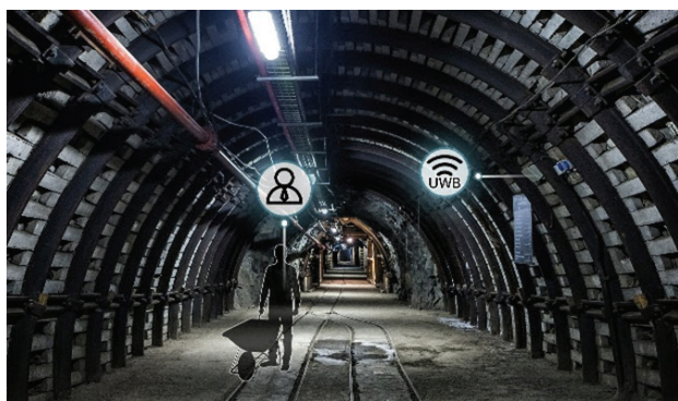
智能隧道 Intelligent Tunnels
