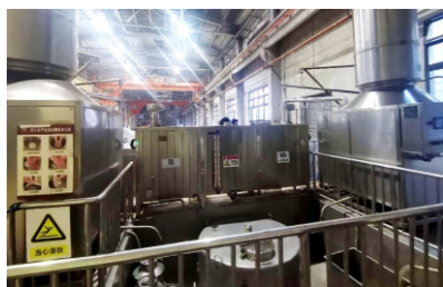
酒甌餘熱回收利用設備
