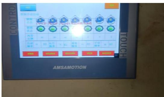
铸锭时联动风机停机，减少温度流失和节约电费
