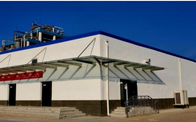
河南农化公司进行多项技术革新和老旧设备更新改造
