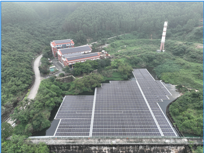
首个新模式的漂浮式光伏电站
