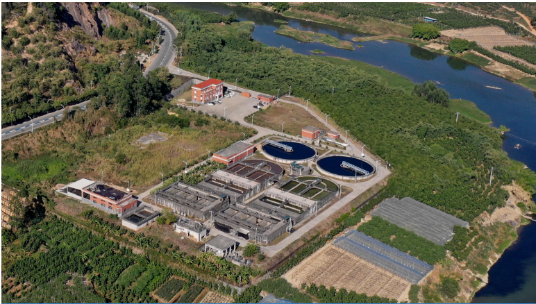
平和县第二污水处理厂
