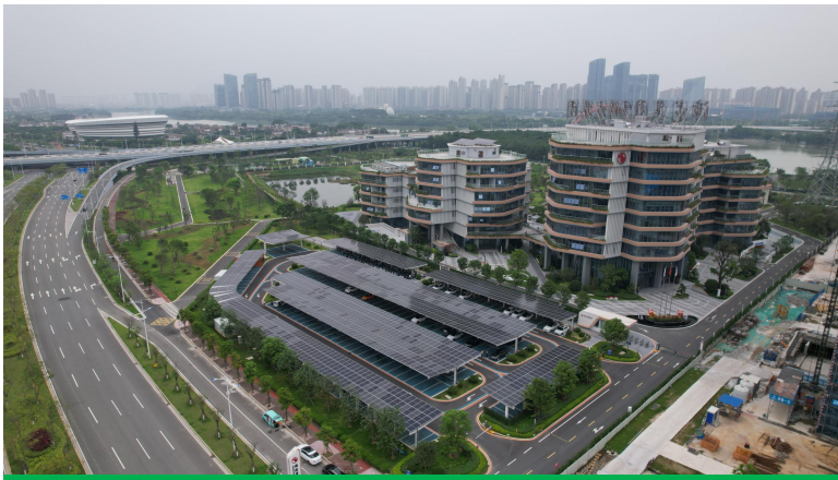
漳龙总部经济大楼“光储充放”综合能源充电站
