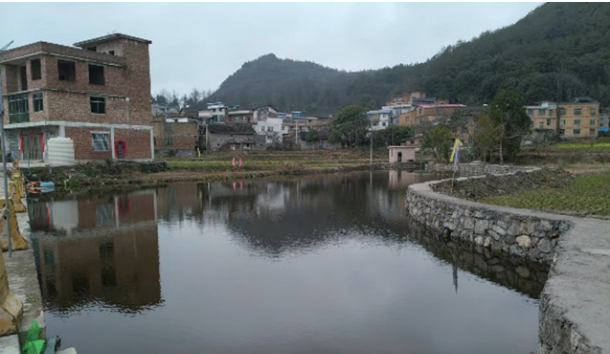
贵州省三都水族自治县中和镇三洞村水根寨灌溉水塘配套设施建设项目
