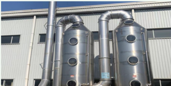
电泳废气安装二级水喷淋处理装置
