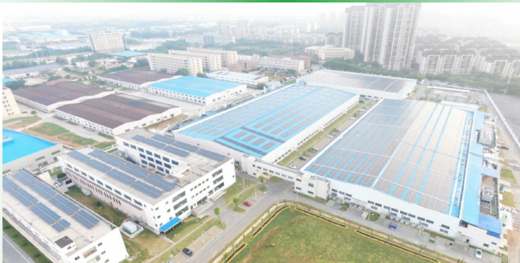
铜陵厂区光伏项目
