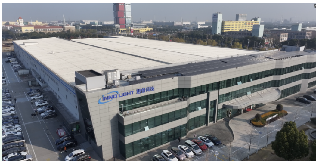
苏州园区分布式屋顶光伏项目
