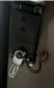
有关不锈钢外壳产品（JP 柜、HSF 电缆分支箱）门锁旁增加接地柱以提升接地连续性
