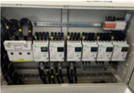
优化电缆分支箱塑壳位置，整体下移以增加顶部散热空间，降低产品温升
