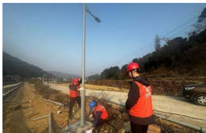
▲ 市政集团安装乡村照明设施
