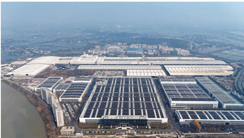
德清中大线缆 - 19.132MWp 光储充一体低碳园区示范项目
