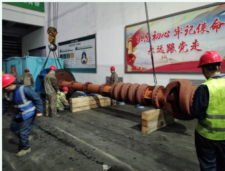
凝结水泵项目改造现场
