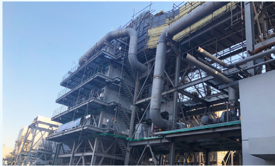
唐山佳华煤化工项目
