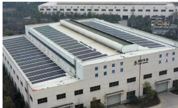
企业车间顶部布设太阳能光伏板
