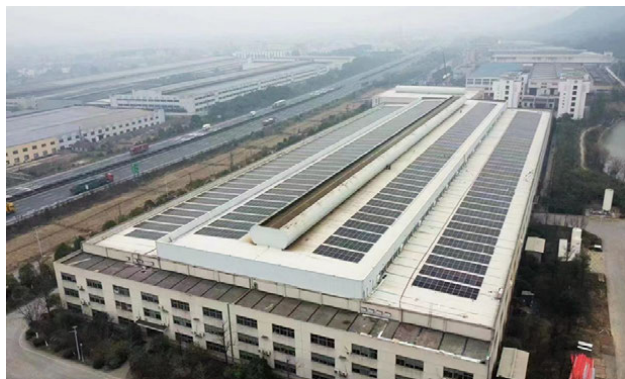
企业车间顶部布设太阳能光伏板
