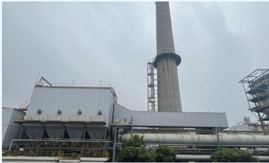
宁波钢铁焦化项目
