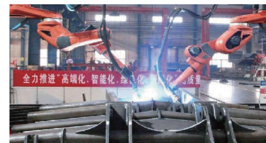
图片：焊接机器人
