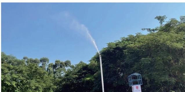
360°高压旋转喷雾立柱
