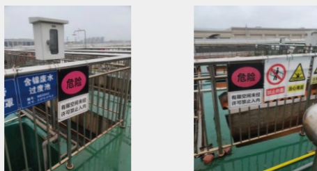
安全隐患排查整改
