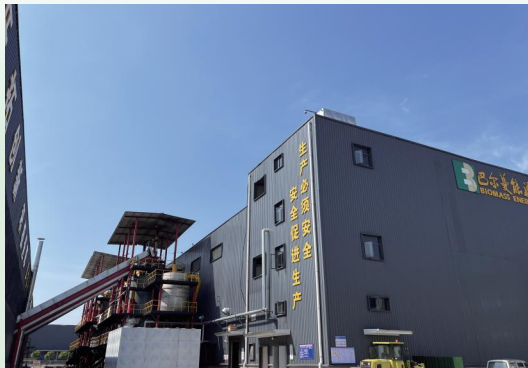
黎川生物质集中供热项目
