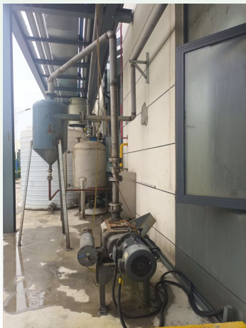
废白土固废减排改造
