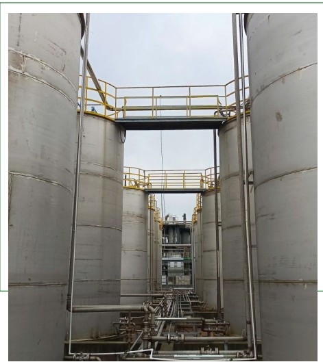
储罐呼吸废气减排改造
