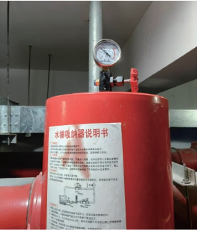
消防泵房水锤整改前
