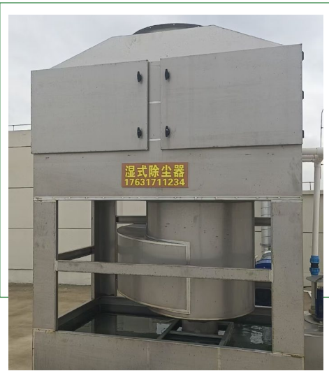
投料粉尘除尘改造
