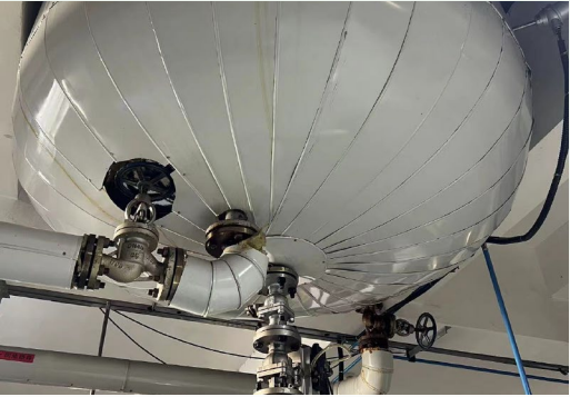
恒尚材料溶胀釜搅拌桨改造
