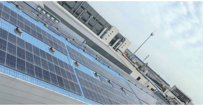
恒尚材料厂房铺设太阳能板
