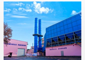
超低排放改造工程
