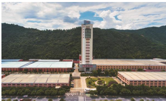
杭电股份电力电缆生产基地位于杭州市富阳经济技术开发区，占地面积 180 亩，主要生产 500kV 及以下中高压交联电力电缆。
