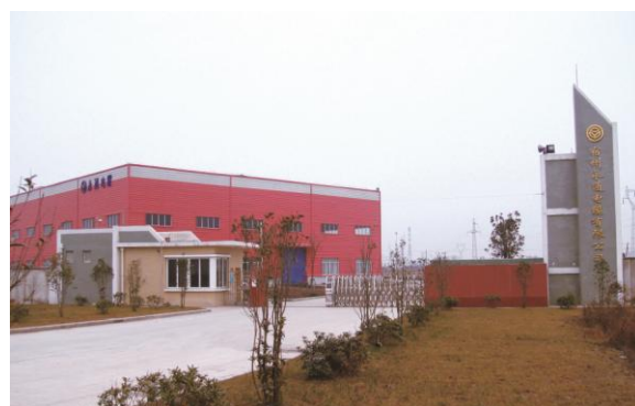
宿州永通电缆有限公司是杭电股份全资子公司位于安徽省宿州经济技术开发区，占地面积 70 亩，作为杭电股份矿用电缆生产基地，主要生产橡套和控制电缆等。
