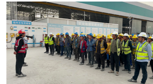
施工班前安全会
