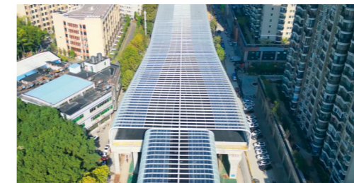
武汉友谊大道快速化改造工程声屏障工程
