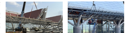
航站楼屋面檩条模块化吊装
