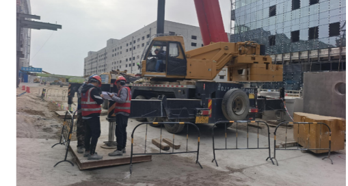
现场安全检查 (记录)
