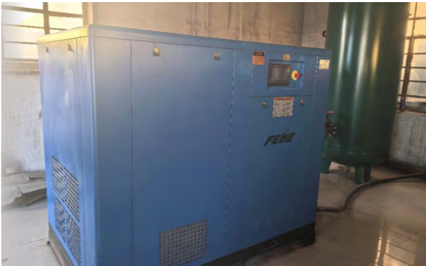
110kW 永磁变频双级压缩空气机
