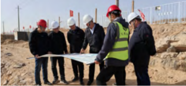
项目现场检查
