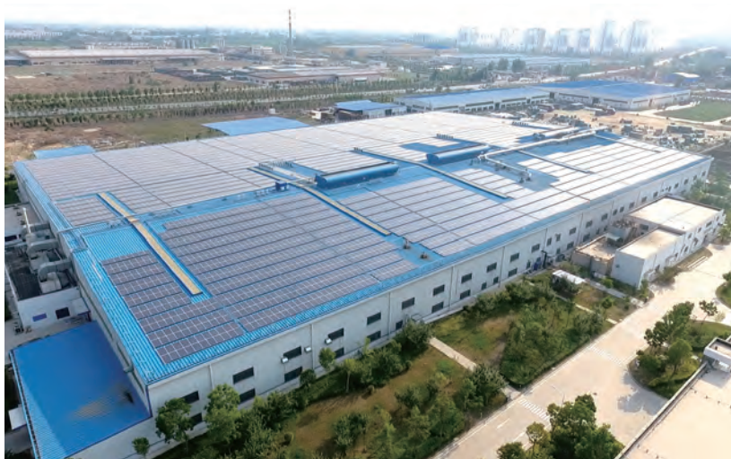
▶ 河南寶鋼分佈式光伏
