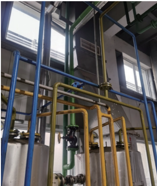
冷却水管路结构改造
