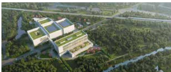
杭州锐健医疗股份有限公司 运动医学及微创骨科产品智能制造项目
