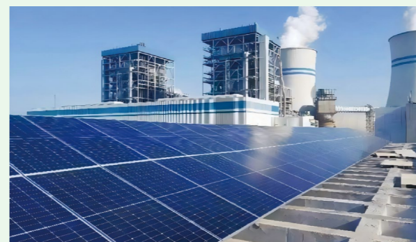
任丘热电 1.303MW 厂区光伏年发电量约 150 万度
