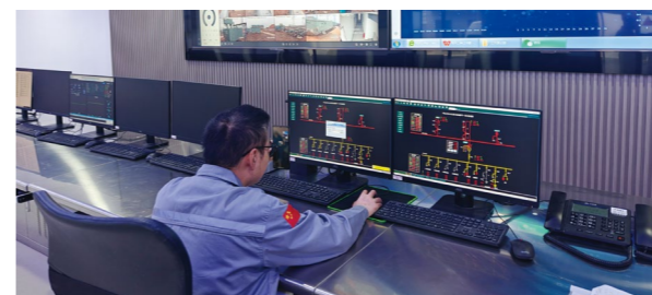
平山县 100MW 光伏发电调试现场
