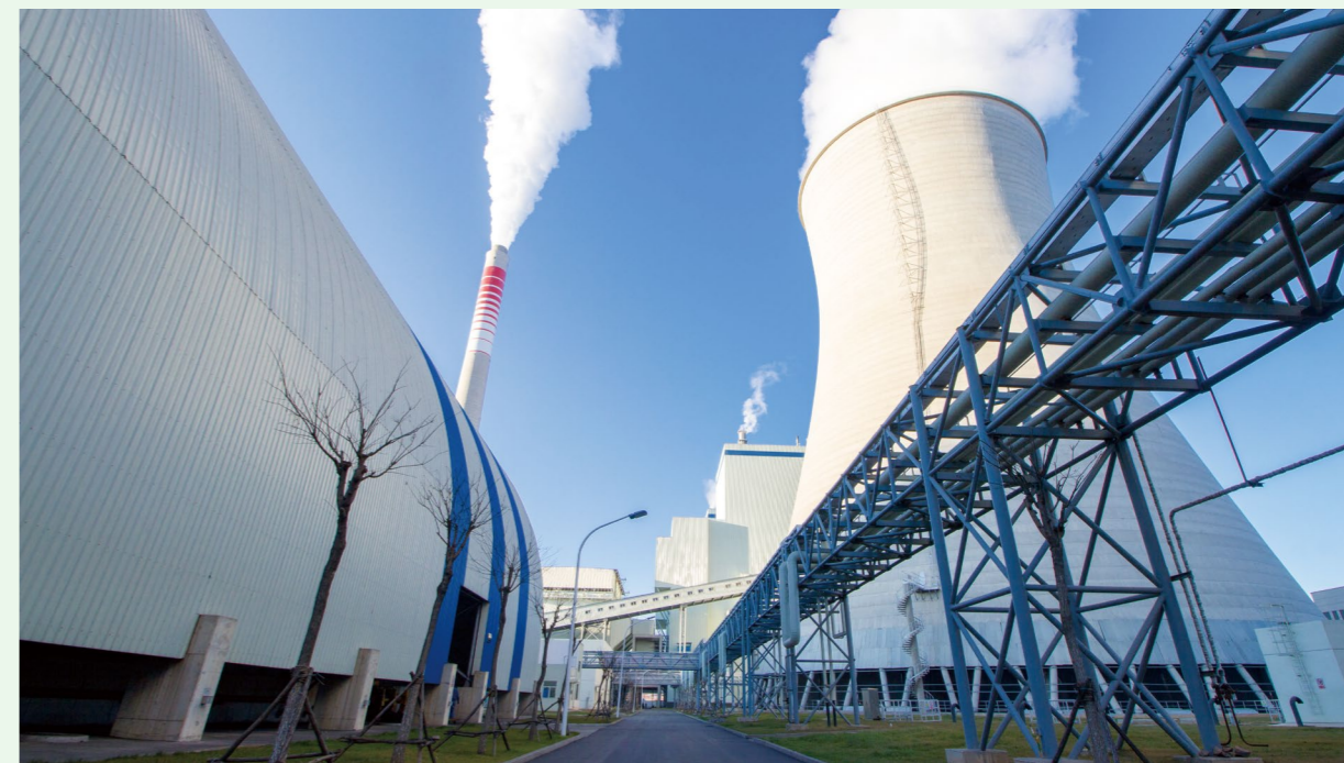
承德热电循环水塔
