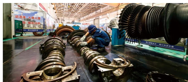
火电机组检修现场
