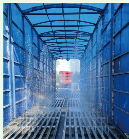
国泰发电设置车辆清洗装置进行除尘
