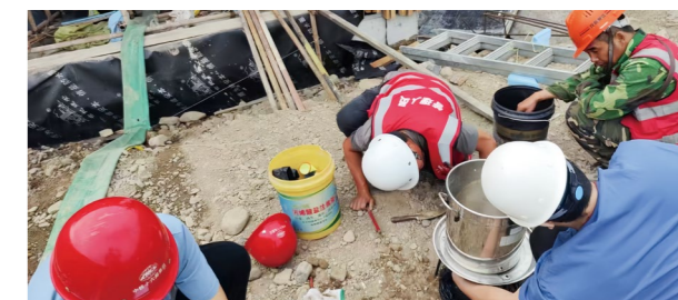
承德热电铁路专用线项目施工
