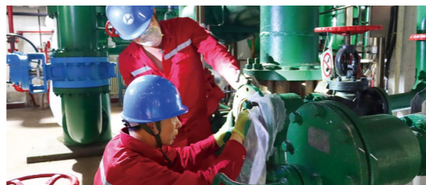
热力系统检修现场
