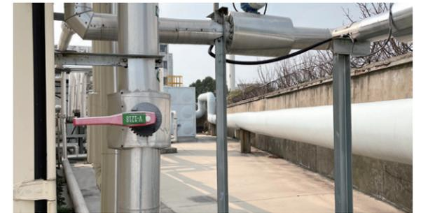
常州基地完成污水站中水回用总表 60 万吨向 40 万吨生活供水表的安装和 CP2 除盐水总表的安装。
