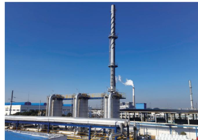
热媒炉低氮氧燃烧改造
